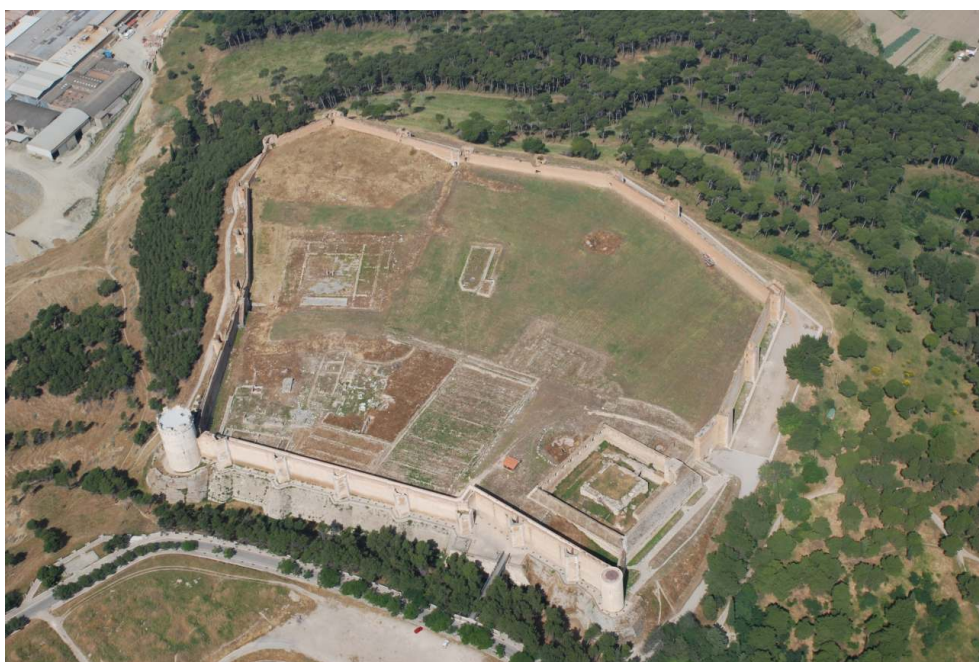
Fig. 1 – La fortezza angioina (XIII secolo) – Vista dall'alto – Archivio fotografico DISTUM dell'Università degli Studi di Foggia (foto. A.V. Romano).
